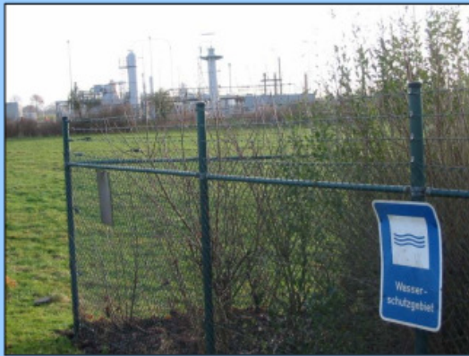
Blick von Brunnen 4 auf die Gastrocknungsanlage des Bohrplatzes GO Z9
