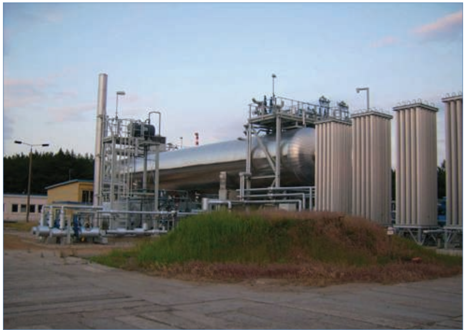
Genehmigungsstreit dauert an: Injektionsanlage Altmark.
