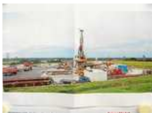
Ausschnitt aus einer Exxon-Präsentation: So sieht das Testgelände in Bad Laer aus.
