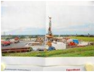
Ob Exxon in Drensteinfurt einen Bohrplatz wie hier in Bad Laer einrichtet, ist noch offen.
