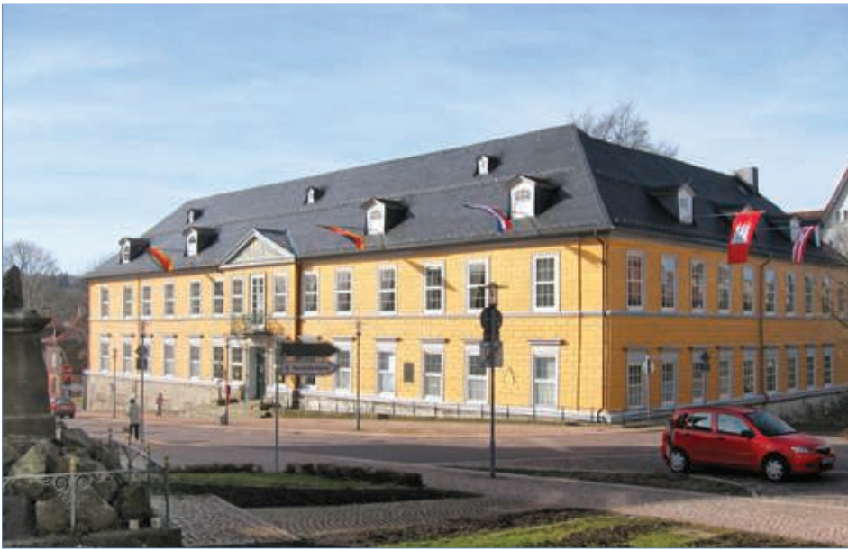
Geschmückt mit den Fahnen des Bundes und der vier Küstenländer, für die das neue LBEG zuständig ist: Das Traditions-Gebäude des ehemaligen Oberbergamts in Clausthal-Zellerfeld – der Hort des ewig Gestrigen.
